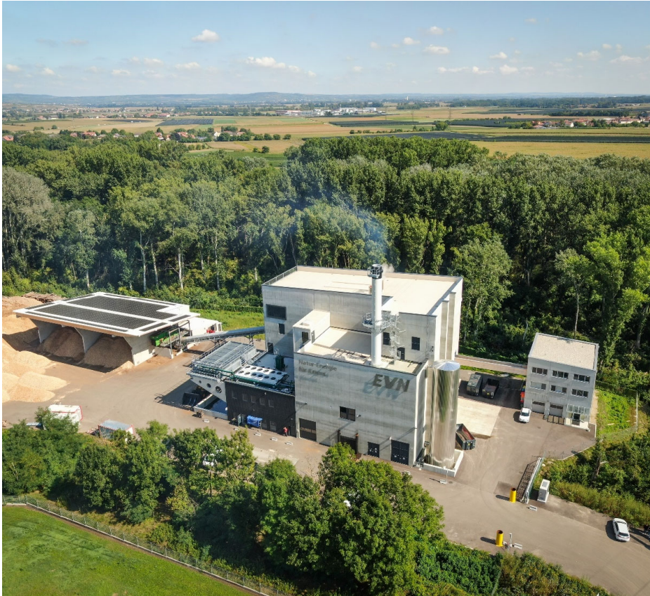
Biomasse KWK-Anlage Krems
