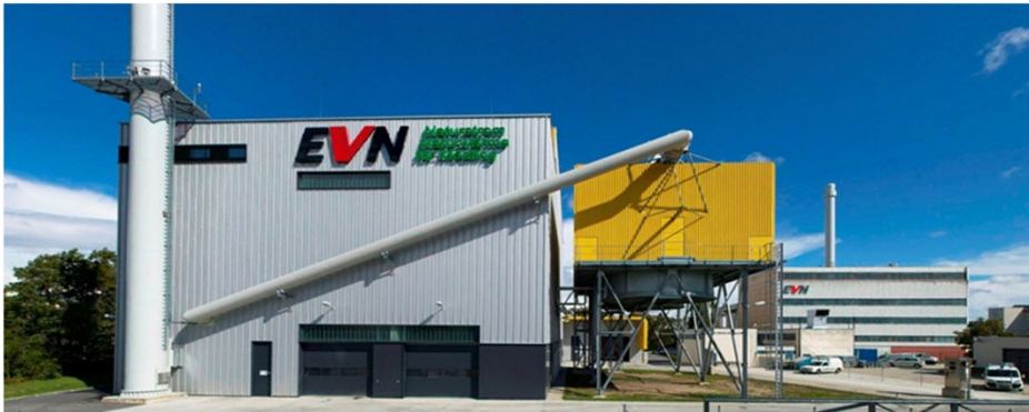
Biomasse KWK Mödling
