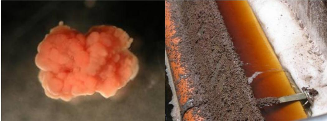
Abbildung 5: Anammoxbakterien bilden frei sichtbare Granulen (links). Anammox- Biomasse im DEMON- Reaktor der ARA Strass im Zillertal (rechts).
