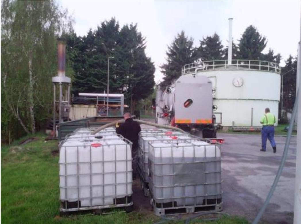
Abbildung 20: Zwischenspeicherung von 10 m<sup>3</sup> Filtratwasser vor Ort für den Abtransport.
