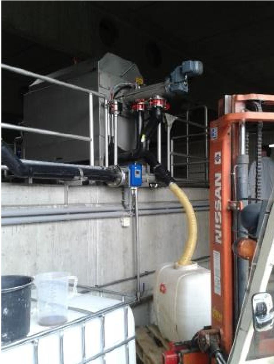
*Abbildung 23: Entnahme der Biomasse für die Untersuchungen aus der Mikrosiebung des Schlammabzugs.*
