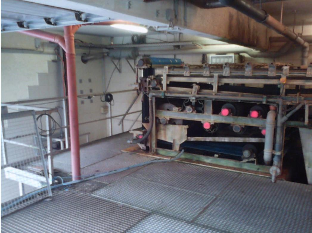
*Abbildung 19: Filtratwasserablauf unter der Kammerfilterpresse der ARA Stockerau mit eingebauter Tauchpumpe für die Entnahme.*
