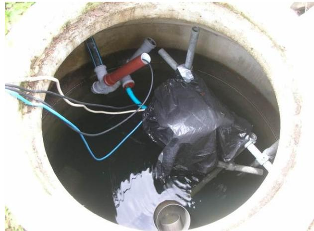
Abbildung 5: Mengenummessung im Ablaufschacht.
