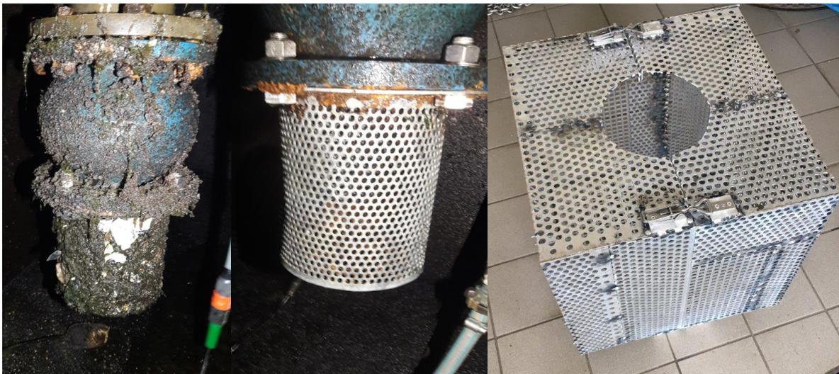
Abbildung 27: Saugkorb der Zulaufpumpe vor (links) und nach (Mitte) Reinigung sowie neuer Saugkorb (rechts)
