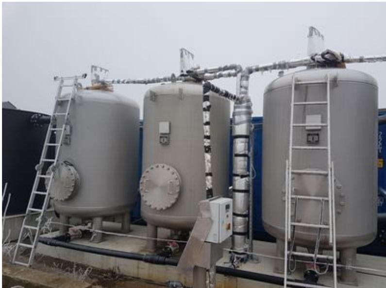
Abbildung 28: Wärmedämmung an der Versuchsanlage
