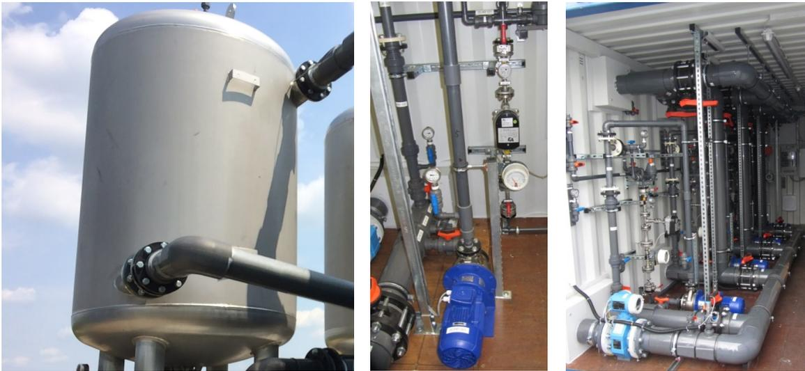
Abbildung 7: Ozonreaktor (links), Injektorpumpe und Gaseintragsstrecke (Mitte), Gaseintragsystem und assoziierte Verrohrung (rechts)
