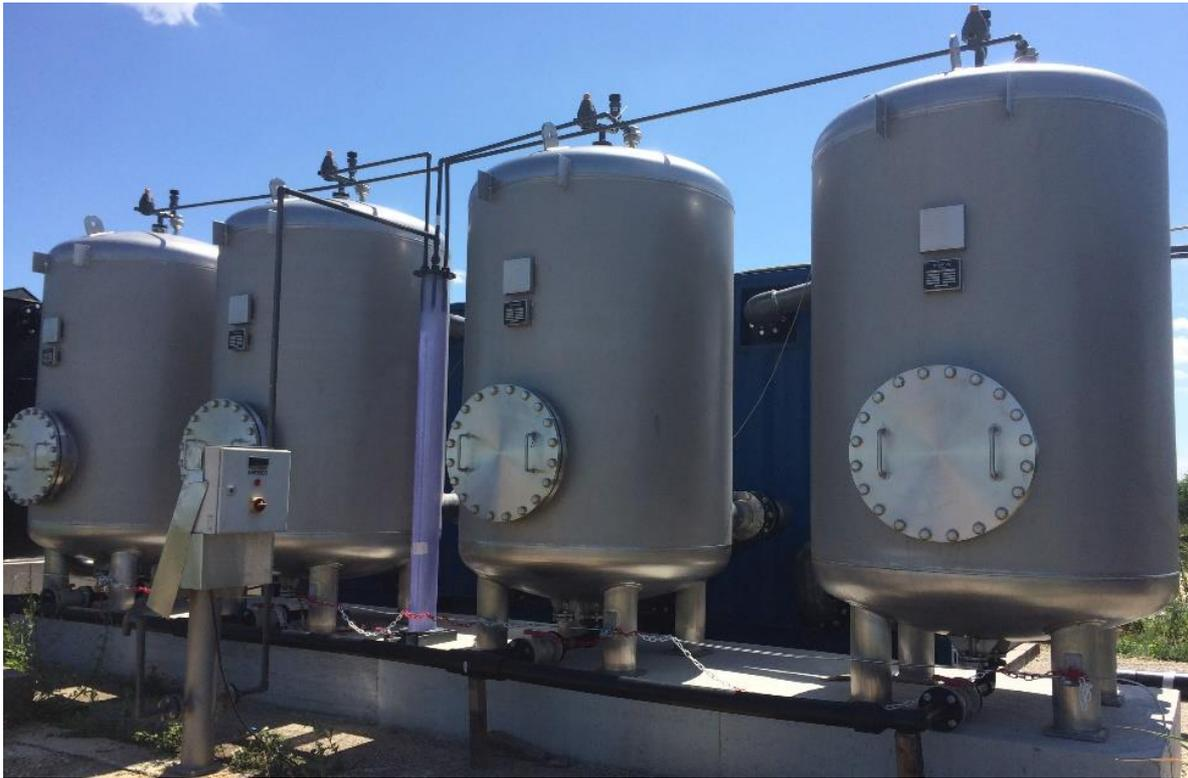
Abbildung 8: Ozonreaktoren mit Offgasverrohrung
