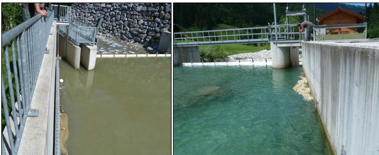
Abbildung 5: Positionierung der Abstiegsklappen am Fritzbach (links) und Kleinarler Ache (rechts).
