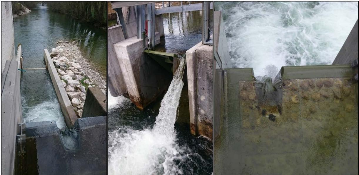
Abbildung 3: Abstiegsanlagen an den Kraftwerken Laganda (links) und Ebewe (Mitte und rechts) in der Seeache.
