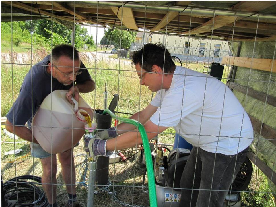
Abbildung 5: Einbringung von Pflanzenöl in den Versickerungspegel
