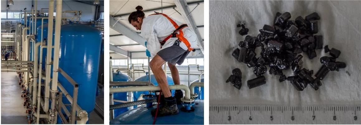
Abbildung 3: Probennahme Aktivkohlefilters 1 „Gaswerk Simmering“ und Aktivkohle „CC50P“ Foto: A. Watzinger
