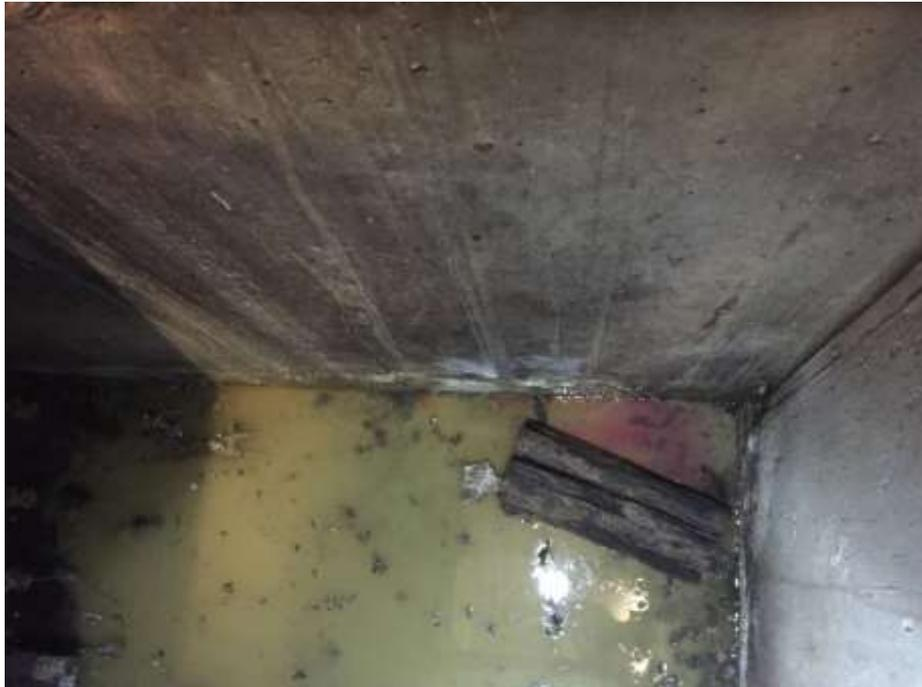
**Abbildung 63: Undichter Schacht im Gebäude mit eingetretener Suspension erkennbar an der violetten Färbung durch das Kaliumpermanganat**
