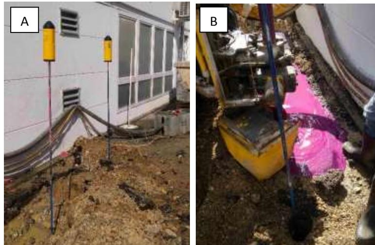
**Abbildung 59: Fotos von den Arbeiten bei der 1. Jet-Kampagne. A: Sonden zur Bestimmung des Durchmessers der 1. Testsäule. B: Jetten der 1. Säule mit Kaliumpermanganat-Suspension, Blick in die Auffangkünette für die Rücklaufsuspension.**
