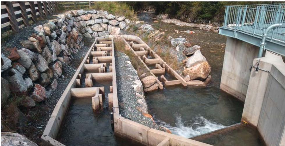
Beispiel: Technische Fischwanderhilfe in Form eines „Vertical Slot Fish Pass“ beim Kraftwerk Hermann & Müller KW an der Fuscher Ache
