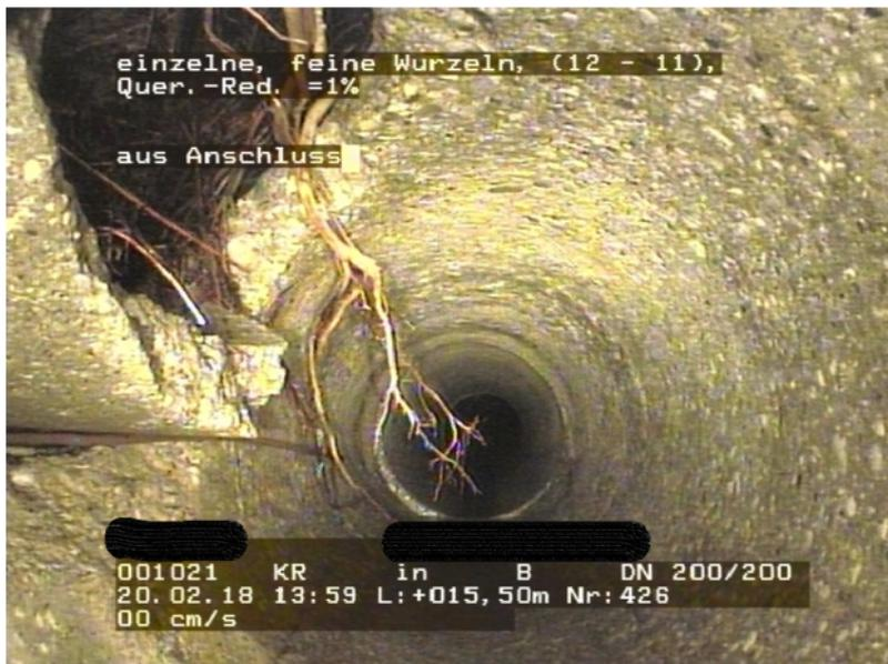
Zustandsdokumentation: Einzelne feine Wurzeln von 12-11 Uhr verursachen eine Querschnittsreduzierung von 1 % der Haltung.
