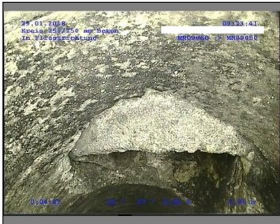
1,39m, Einragender Anschluss, einrag. Länge als Prozentanteil des Durchmessers: 15 %, bei 2 Uhr
