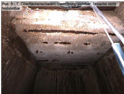
Zustandsdokumentation: Oberflächenschaden, Bewehrung sichtbar an Position zwischen 05 – 07 Uhr, Ursache nicht feststellbar.
