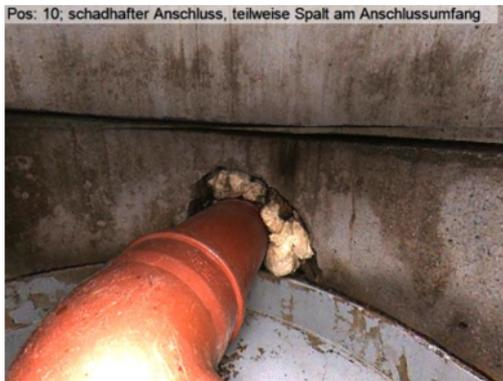
Zustandsdokumentation: Schadhafter Anschluss auf 10 Uhr, teilweise Spalt am Anschlussumfang.
