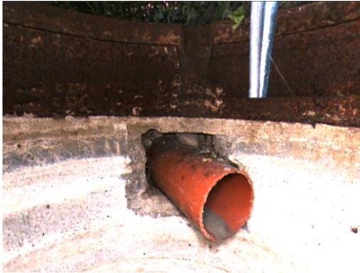
Zustandsdokumentation: Hohlraum sichtbar bei Position 03 Uhr.
