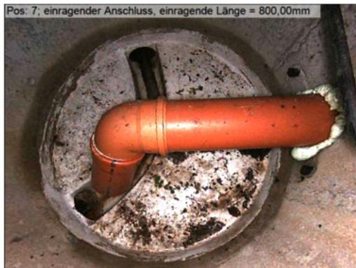
Zustandsdokumentation: Einragender Anschluss mit einer Länge von 800 mm Länge auf 07 Uhr.
