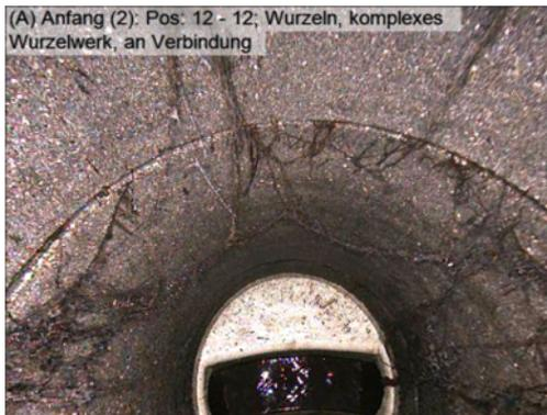
Zustandsdokumentation: Komplexes Wurzelwerk an Verbindungen.
