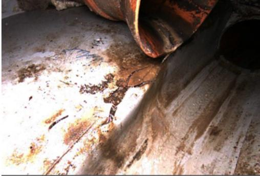
Zustandsdokumentation: Schadhafte Innenauskleidung – Riss von 11 mm in der Auskleidung bei Position 05 Uhr.
