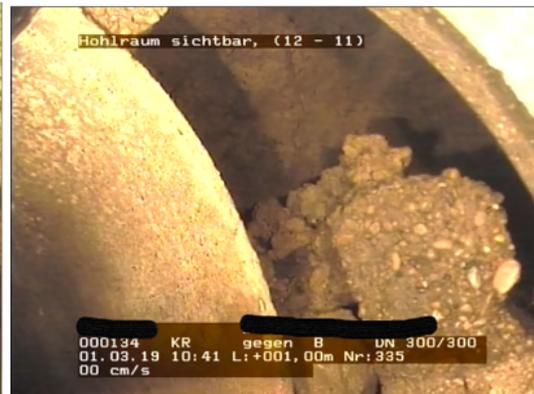
Zustandsdokumentation: Hohlraum sichtbar bei Position 03 Uhr.
