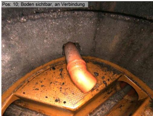
Zustandsdokumentation: Boden sichtbar an Verbindung bei Position 10 Uhr.
