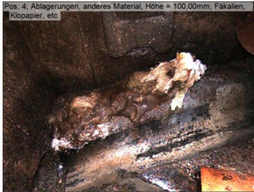
Zustandsdokumentation: Ablagerungen, anderes Material (Fäkalien und Kloppapier) mit einer Ablagerungshöhe von 100 mm.
