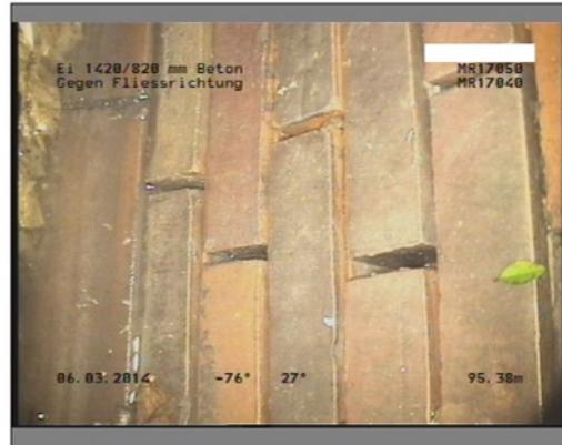
95,38m, Fehlender Mörtel, Tiefe zw. Mauerwerks- und Mörteloberfläche: 30 mm, von 3 bis 6 Uhr
