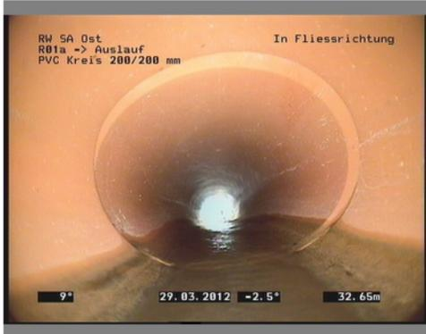
Zustandsdokumentation: Vertikale Deformation, zwischen 09 und 03 Uhr; Die Haltung hat sich gegenüber der Ursprungsform zu 15 % deformiert.
