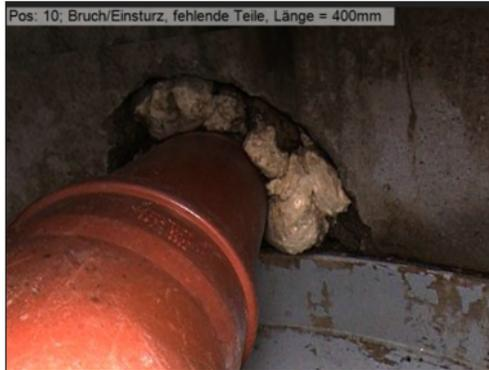
Zustandsdokumentation: Bruch, fehlen von Teilen auf einer Länge von 400 mm.
