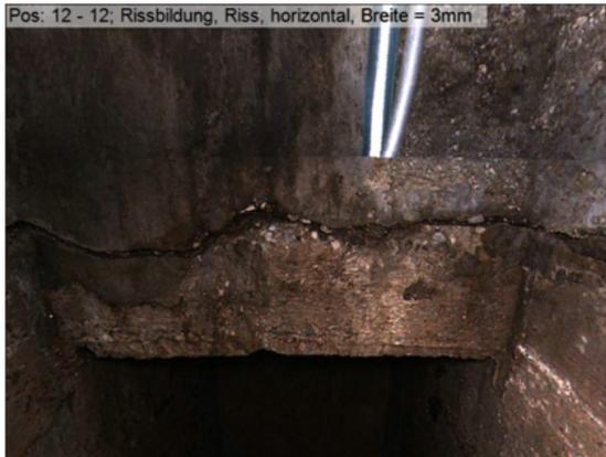
Zustandsdokumentation: Horizontalriss mit 3 mm Rissbreite von 12-12 Uhr.
